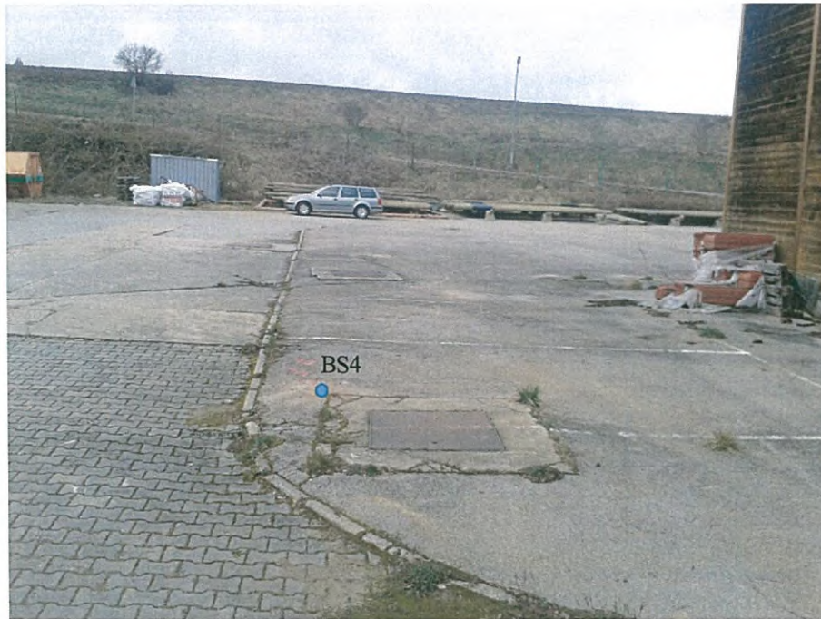
Foto 1: Bereich Erdtanks, Blickrichtung Nordwest
