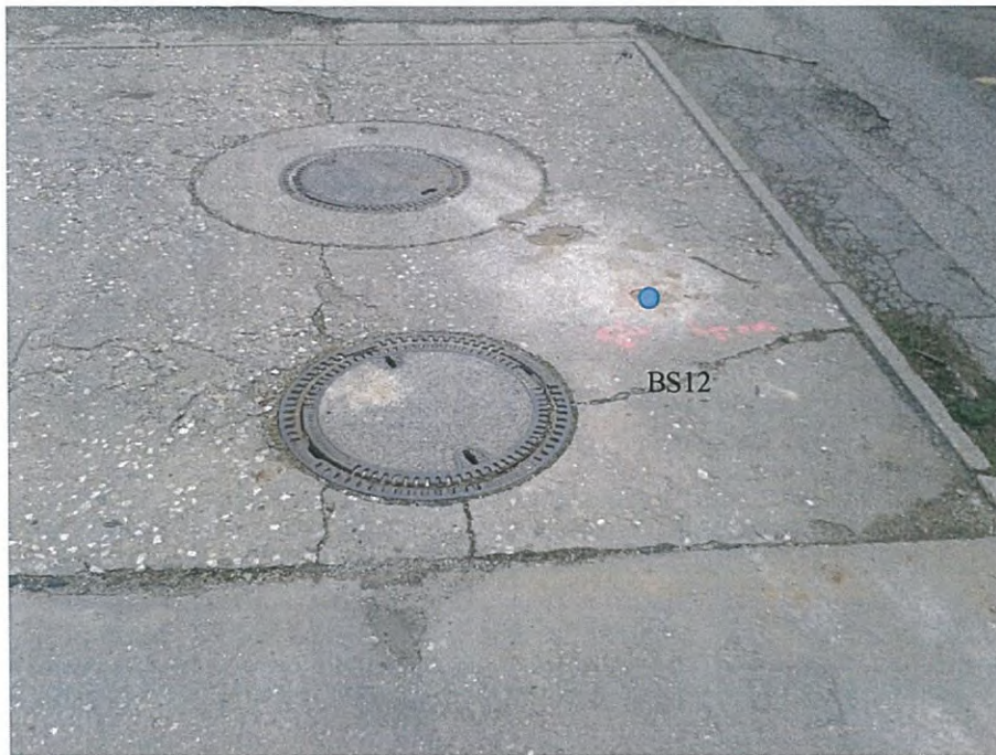
Foto 5: Detail Abscheideranlage bei Erdtanks (Bohrung BS12)
