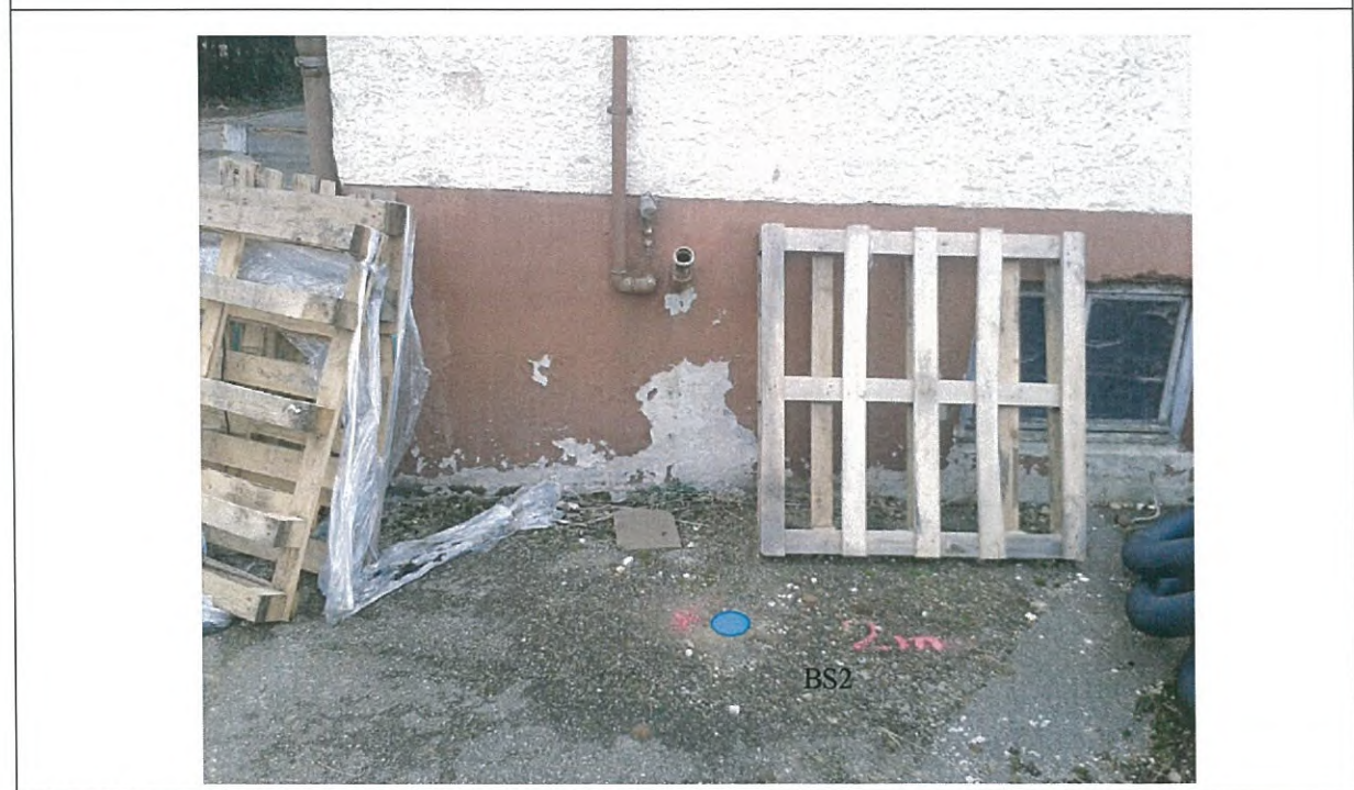
Foto 8: Betankung Heizöltank Keller Lagerhaus (Bohrung BS2)
