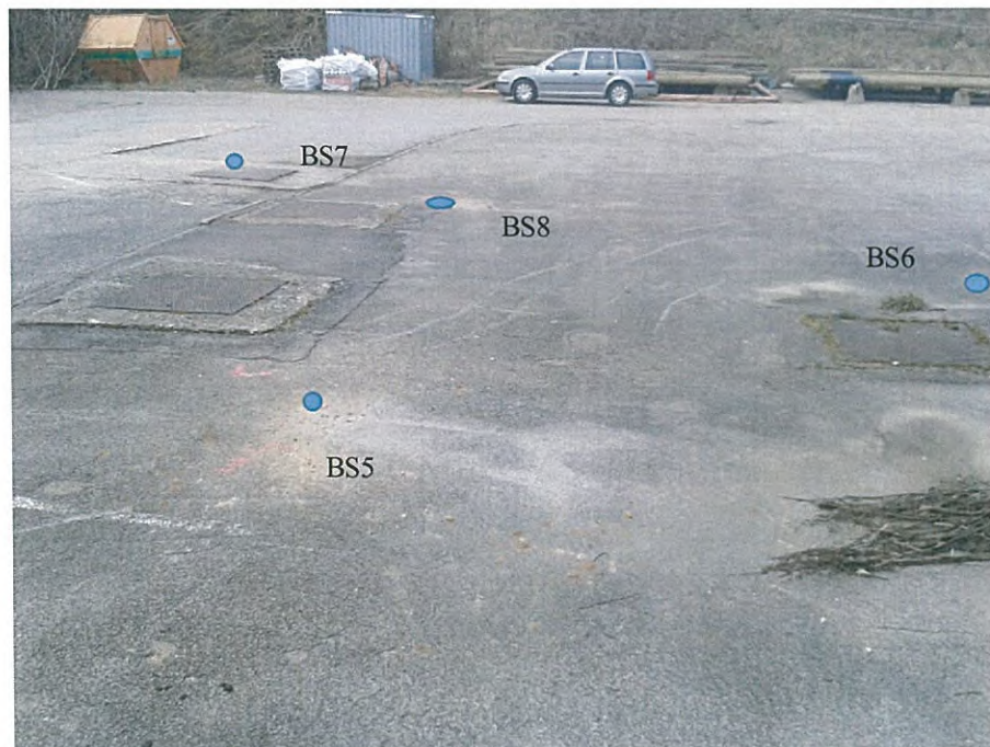
Foto 2: Bereich Erdtanks, Blickrichtung West
