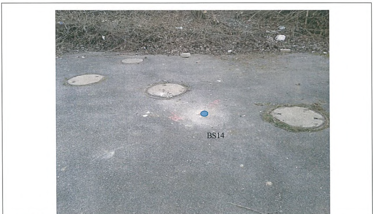
Foto 7: Abscheideranlage vor Waschhalle (Bohrung BS14)
