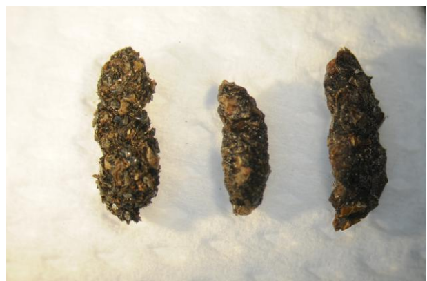
Abb. 20: Kotpellets von Fledermäusen im Dachgeschoss sowie vereinzelt im ersten und zweiten Stock.
