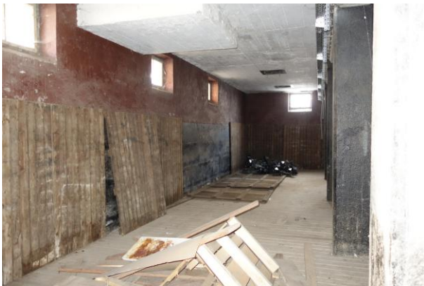
Abb. 17: Saatgutlager Erdgeschoss. Keine geeigneten Strukturen für Hangplätze vorhanden.
