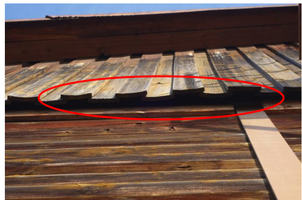
Abb. 24: Die Spalten hinter der Holzverkleidung sind als Tagesquartier für Fledermäuse nutzbar.
