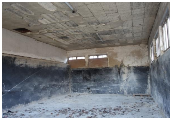
Abb. 12: Innenansicht Garage als Teil des Werkstattgebäudes.
