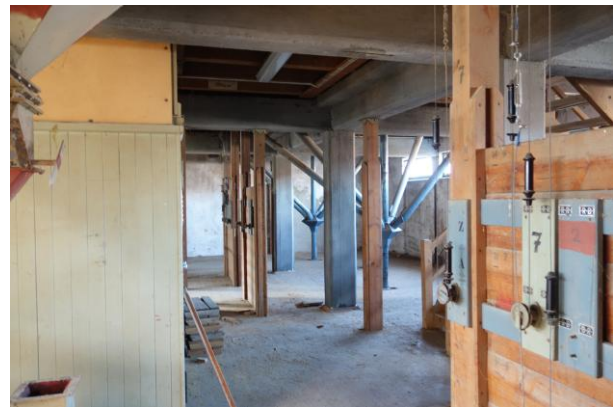
Abb. 18: Erster Stock Saatgutlager. Mögliche Hangplätze im Deckenbereich und Holzverkleidungen.
