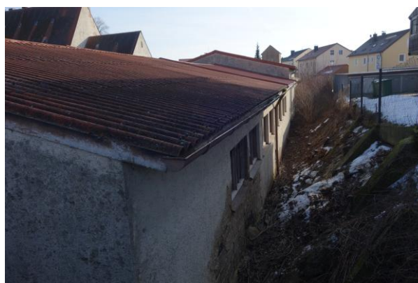
Abb. 14: Rückansicht des Werkstattgebäudes.
