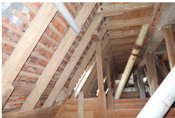
Abb. 19: Dachgeschoss mit Fledermausquartieren hinter
