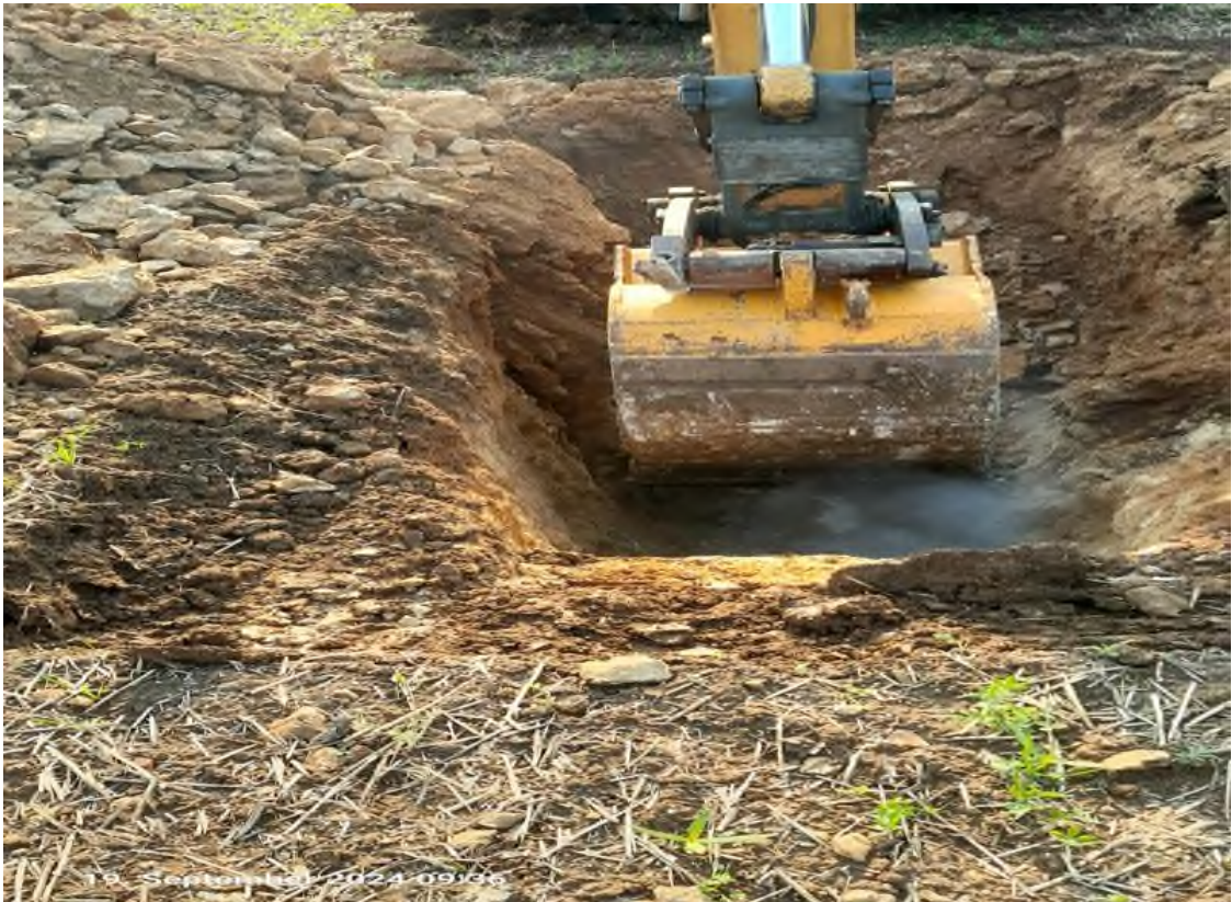
Bild 3: Baggerschurf U 2, Ausführung der Schürfgrube (Baggerschaufel)
