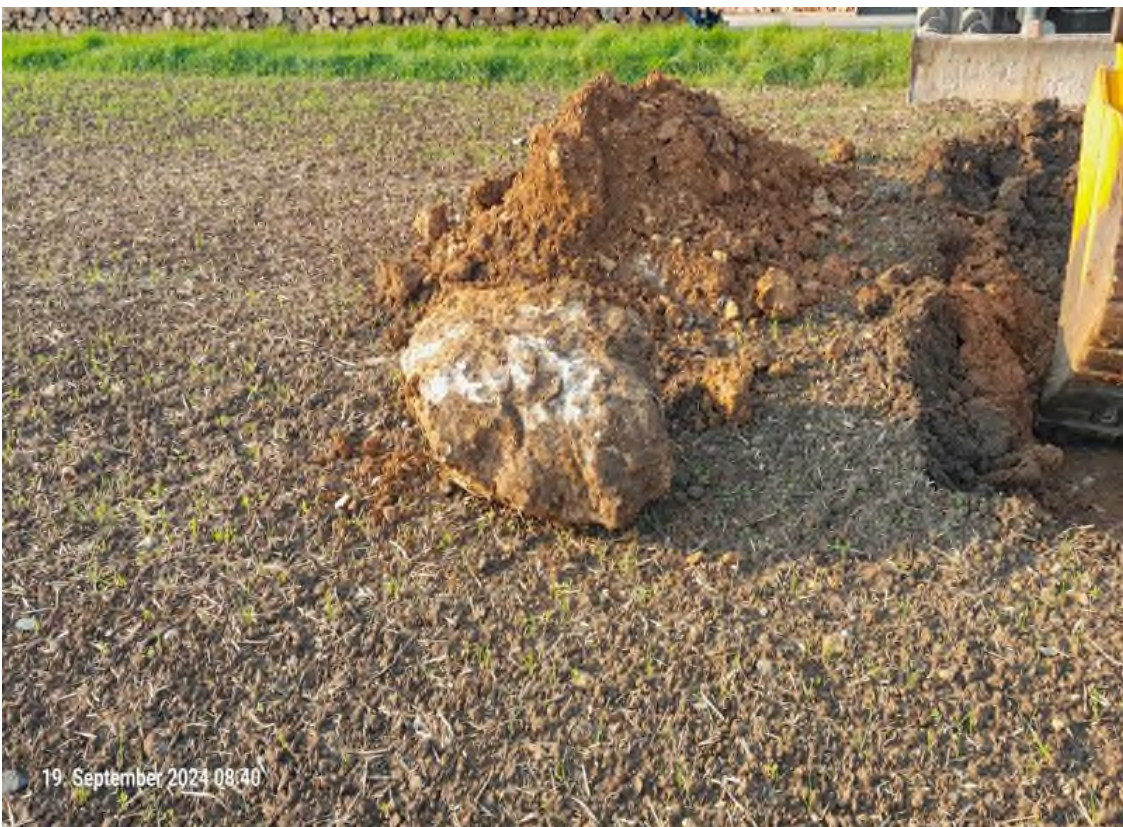
Bild 2: Baggerschurf U 1, Aushub der Steine, Blöcke
