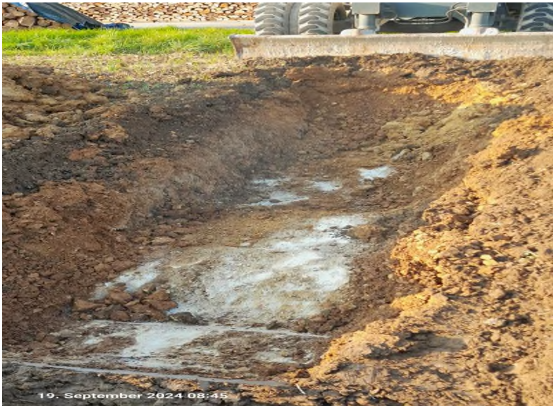
Bild 1: Baggerschurf U 1, Schurfgrube, T= 0,7 m glatte Felsoberfläche (Kalkstein/Dolomit)
